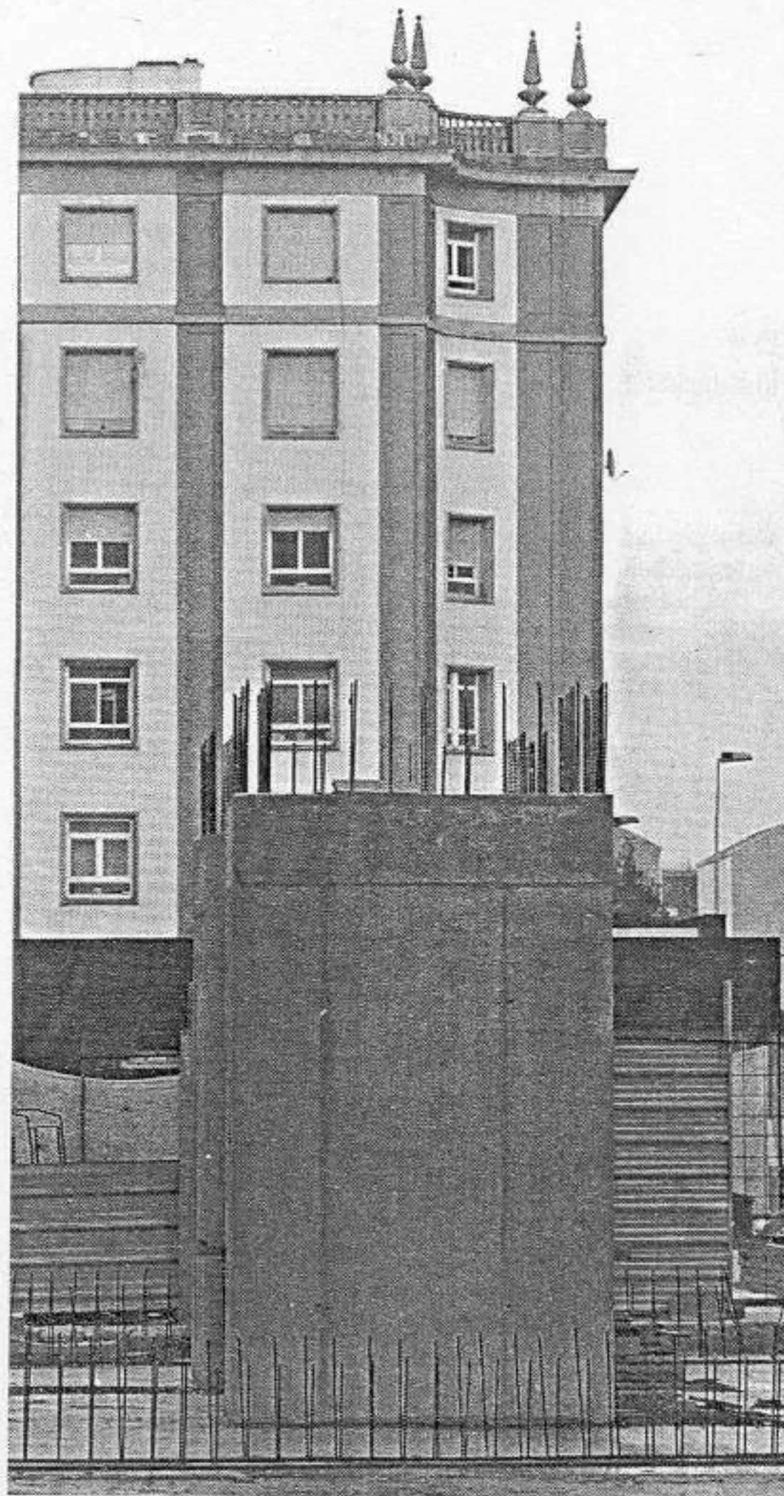
En la plaza son visibles los pilares para el edificio
