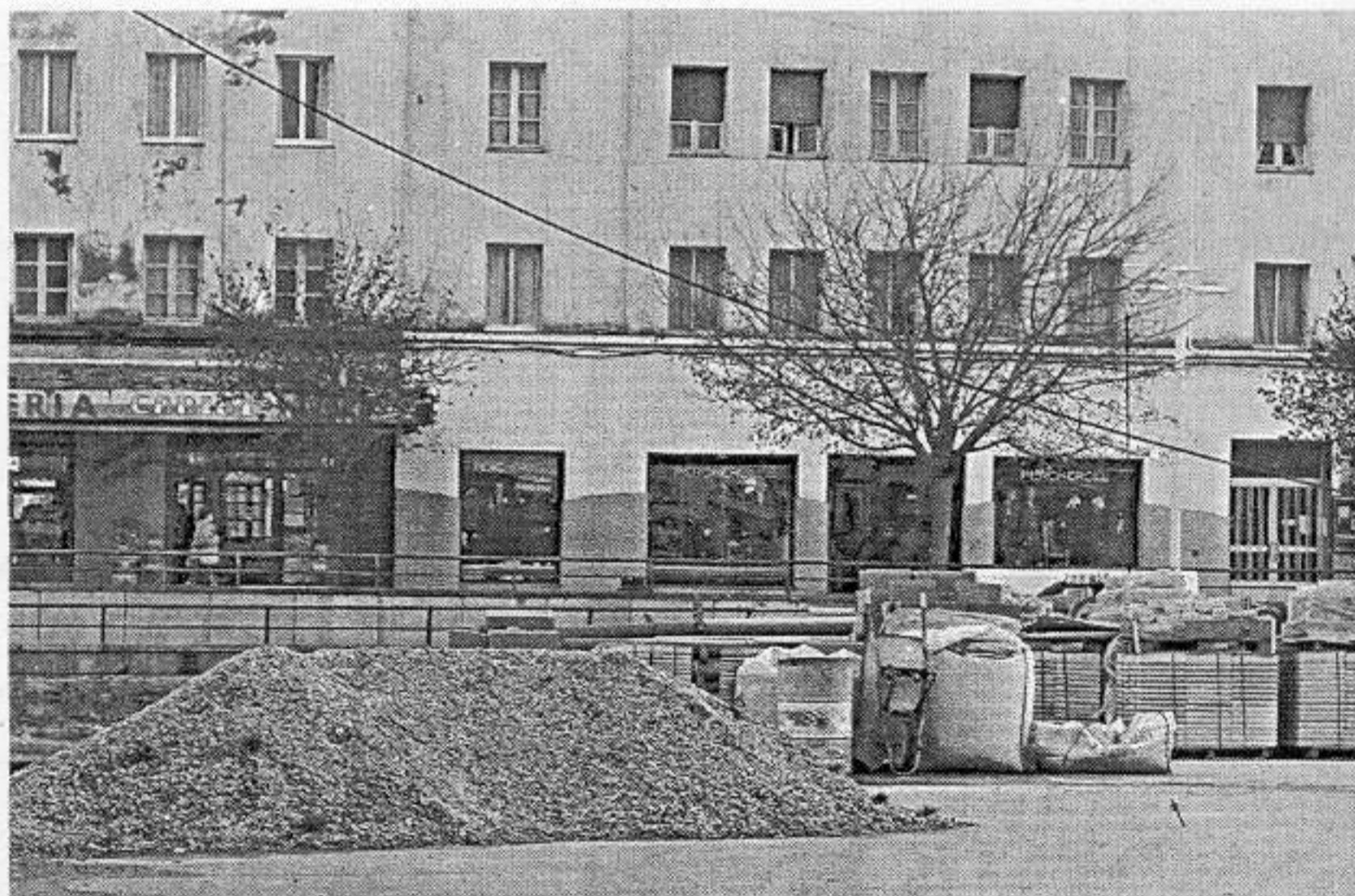
Las obras de la superficie de la plaza saldrán a concurso a principios de 2008
